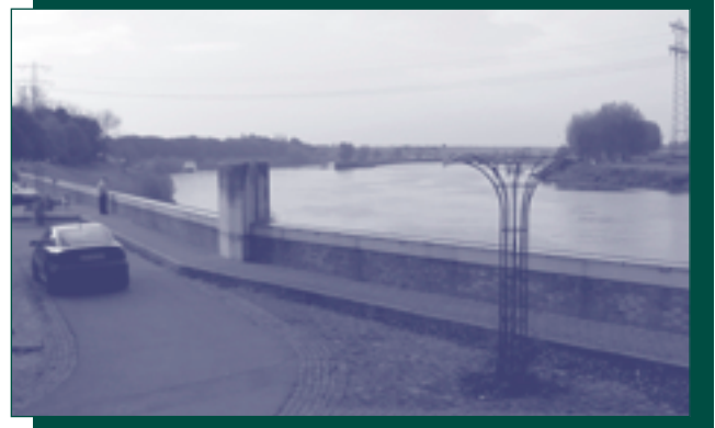
De kademuur in de Maashoek
